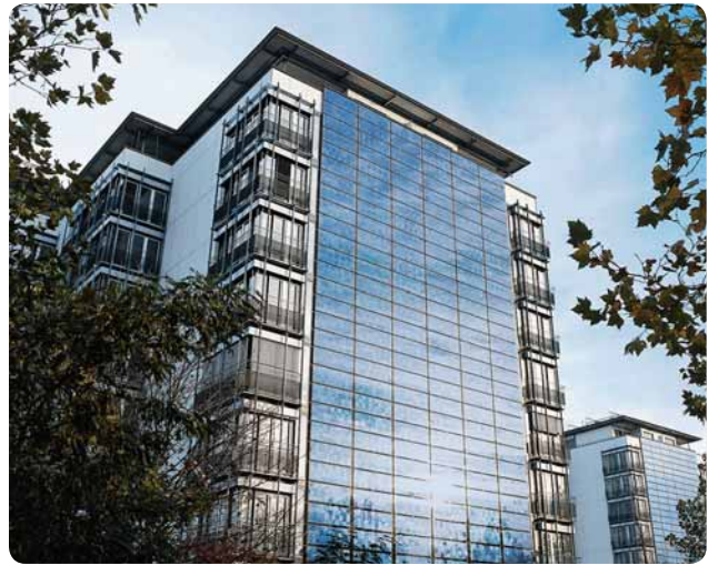
Wohngebäude, 2 x 27 kWp, Freiburg i. Br.
