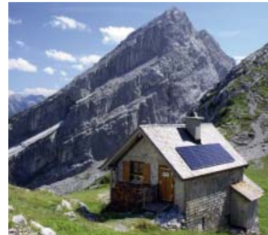
Kleine Inselanlage für eine Berghütte Small stand-alone system for a mountain hut
