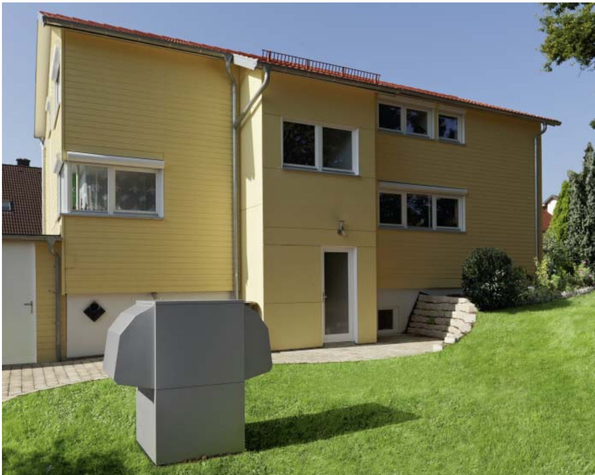
Einfamilienhaus mit Luft/Wasser-Wärmepumpe
