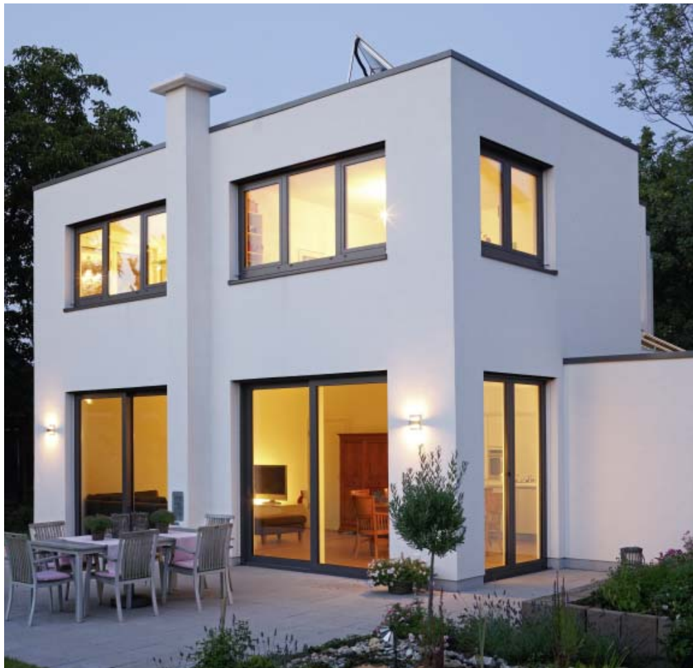
Einfamilienhaus mit Sole/Wasser-Wärmepumpe und Solarthermie
