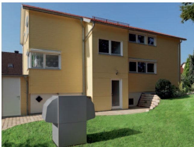
Einfamilienhaus mit Luft/Wasser-Wärmepumpe
