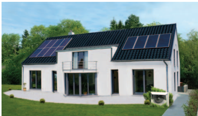
Einfamilienhaus mit Hybrid-Wärmepumpe, Solarthermie- und Photovoltaikanlage
