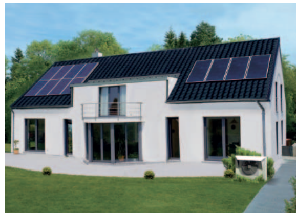
Einfamilienhaus mit Schüco Hybrid-Wärmepumpe, Solarthermie- und Photovoltaikanlage
