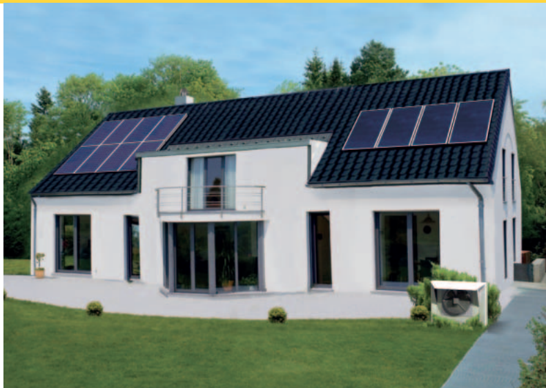
Einfamilienhaus mit Schüco Hybrid-Wärmepumpe, Solarthermie- und Photovoltaikanlage
